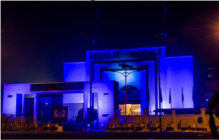
Photo 21 : Le bâtiment du Conseil Consultatif de la Refondation du Niger illuminée en bleu
